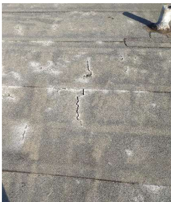
Φωτογραφία 1: Φθορά στην οροφή των παλαιών εργαστηρίων
